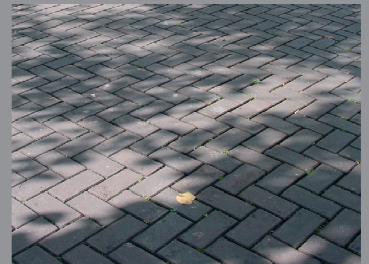
Wegen bestraat met gebakken klinkers
